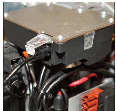
**!** Инструмент для диагностики включает соединительный кабель с разъемом RJ45. Он должен использоваться только с горелками Ecoflam, оборудованными менеджерами горения Thermowatt E-BCU для газа или жидкого топлива. Перед подсоединением/отсоединением прибора отключите электропитание горелки с целью предотвращения удара электрическим током или повреждения оборудования.
